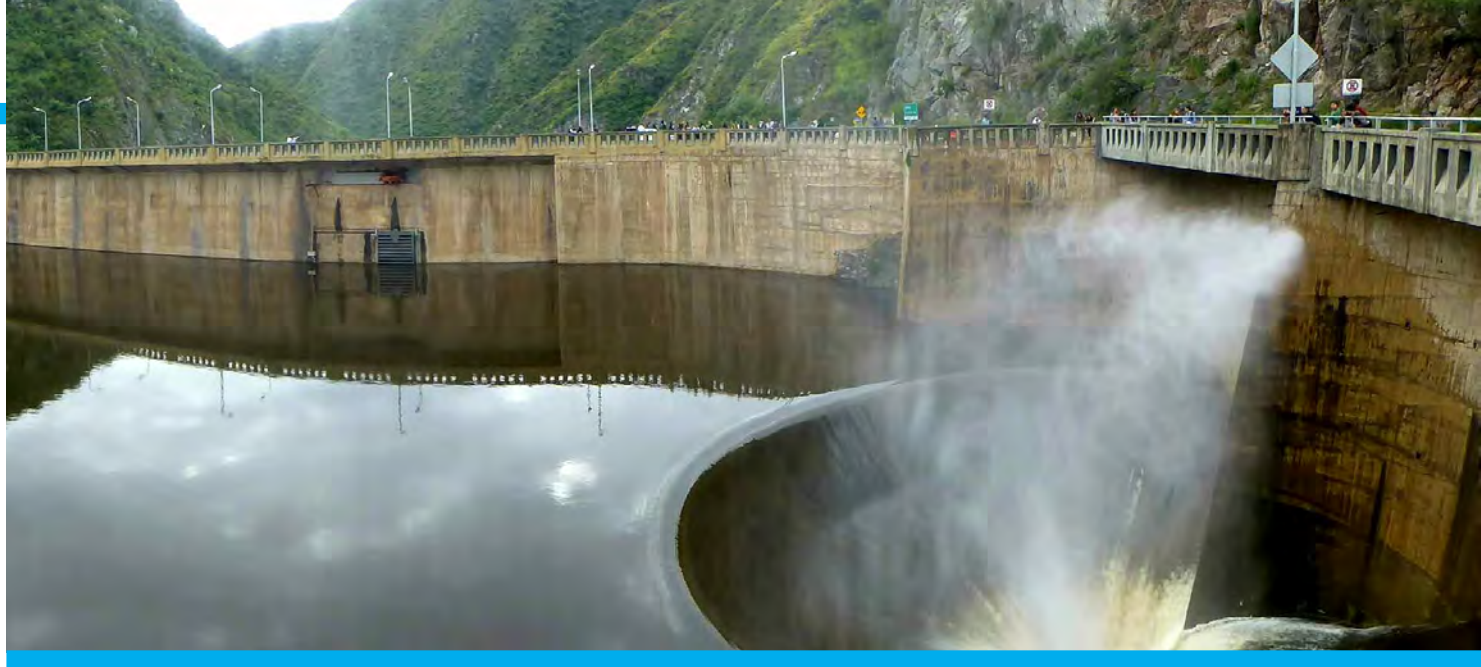
Figura 7. El Embalse San Roque es una fuente que abastece el 70% del agua potable para la ciudad de Córdoba con 1.5 millones de habitantes, además de tener uso multipropósito destinado a riego y energía hidroeléctrica para la región, atenuación de crecidas, desarrollo de actividades recreacionales y turismo. Foto: E. Piovano.
