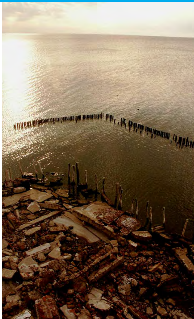
Figura 4. Región costera de Miramar afectada por el aumento de la laguna Mar Chiquita. Pueden verse diferentes protecciones o "empalzados" efectuados durante el aumento de nivel de la laguna para resguardar las construcciones de la erosión por el oleaje. Foto: E. Piovano.
