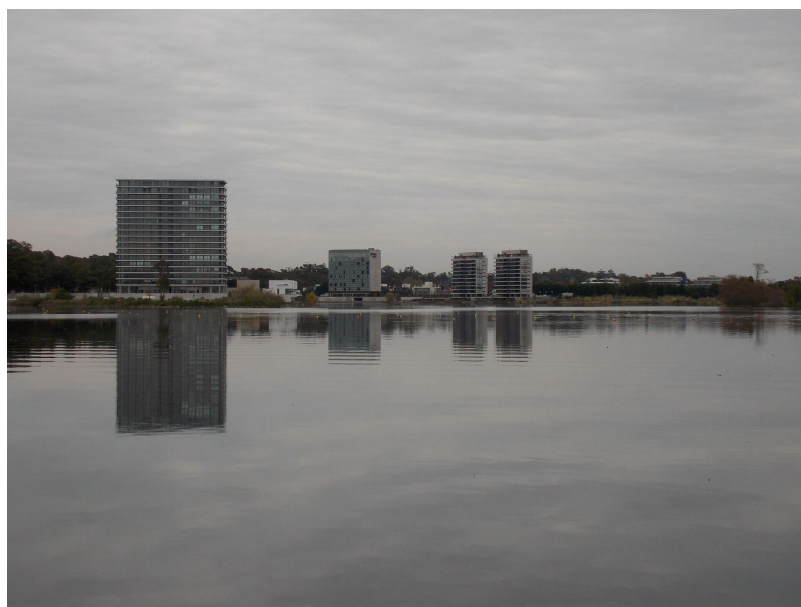
Figura 5. Torres náuticas y hotel construido en el margen del Lago Botavara sobre Avenida de las Américas
