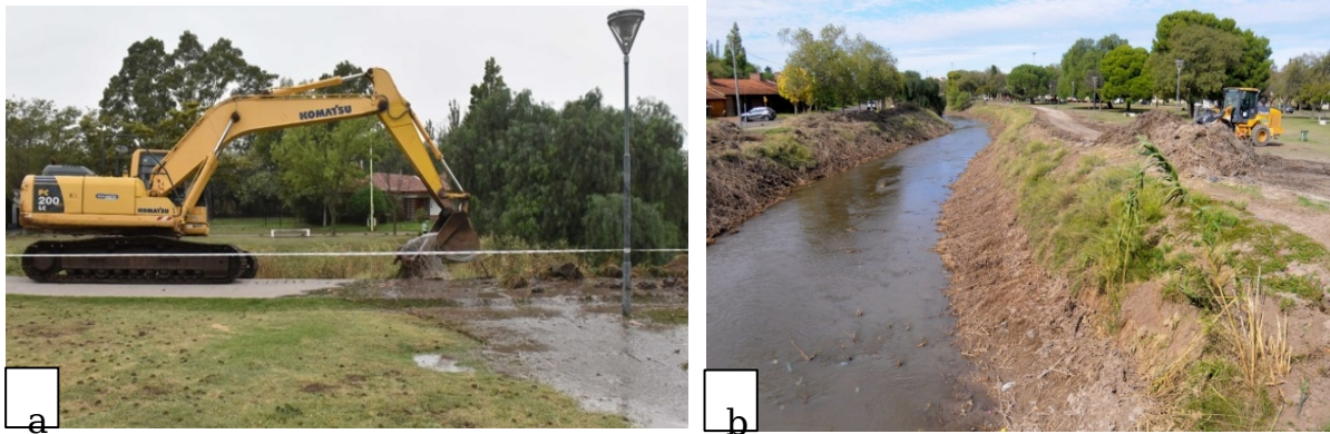
Figura N° 3: Intervenciones alusivas a la etapa previa (a) y posterior (b) a la limpieza mecánica del arroyo Napostá Grande en el Paseo de las Esculturas
