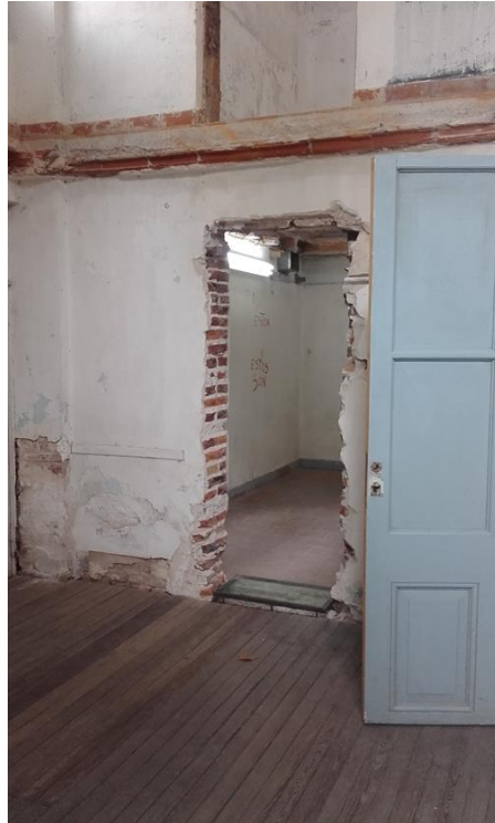
Imagen 1: Puerta (re)abierto tras la demolición colectiva, 28/9/2018
