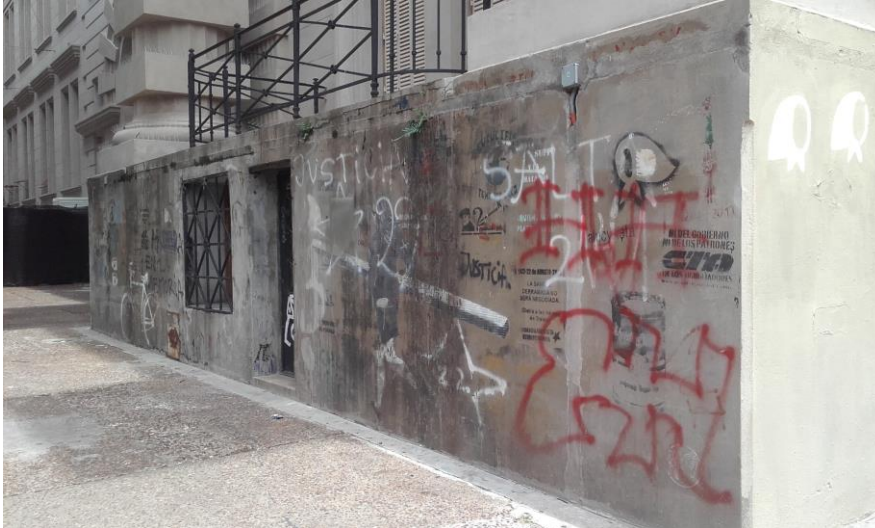
Imagen 3: Fachada del ex CCD antes del revoque, 23/1/2019.
