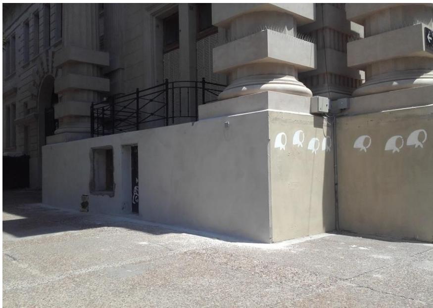
Imagen 4: Fachada del ex CCD luego del revoque, 8/2/2019.
