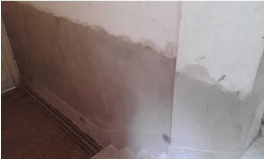
Imagen 5: Revoque en el hall de ingreso del ex CCD, 23/1/2019.
