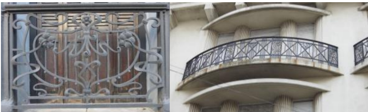
Baranda de balcón de formas art nouveau (residencia privada); balcón con barandas de afiliación art déco (Palacio Piria, Arqs. Isola y Armas, 1928).
