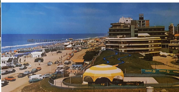
2. Avenida 1 y Paseo 123, 1984
