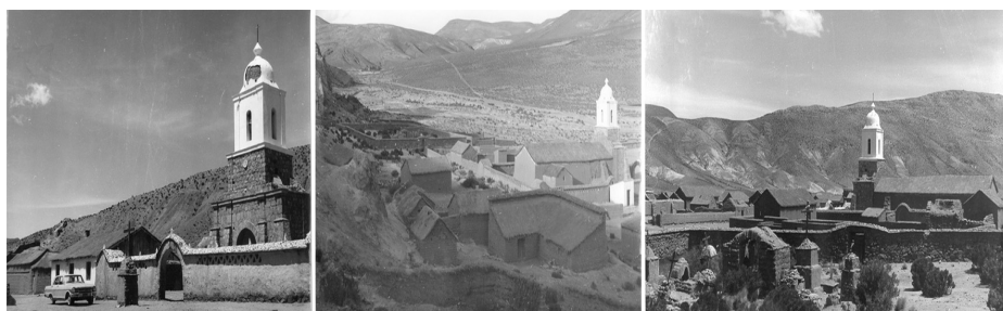
Figura 6. Imágenes de la iglesia de la torre única en 1970. (izq.) frente y vistas desde el sur (centro) y desde el norte (der.) (Fuente: Federico Ortiz, 1970 -CEDODAL-).
