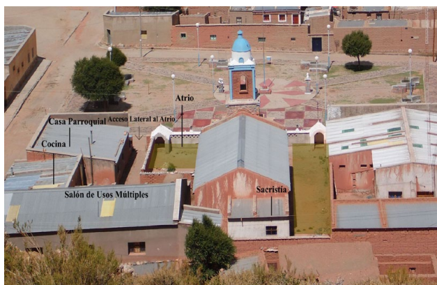
Figura 8. Complejo actual de la iglesia y sus edificios asociados con la modificación del atrio (Fuente: fotografía propia con agregados).
