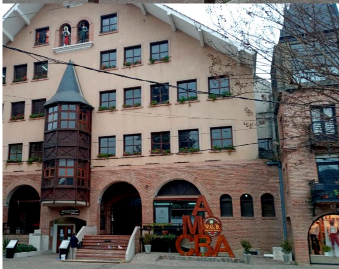
Figura 1: Escultura AMOCBA a horas de su instalación con el hormigón a la vista.
