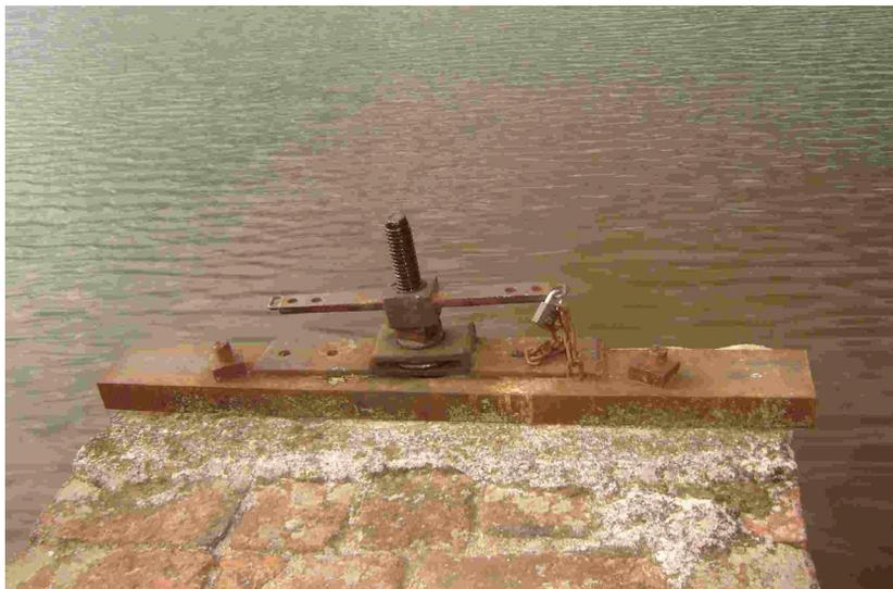
**Figura 20:** Compuerta de Salida ubicada sobre el muro aguas arriba. Vista de la descarga por el conducto de salida.
