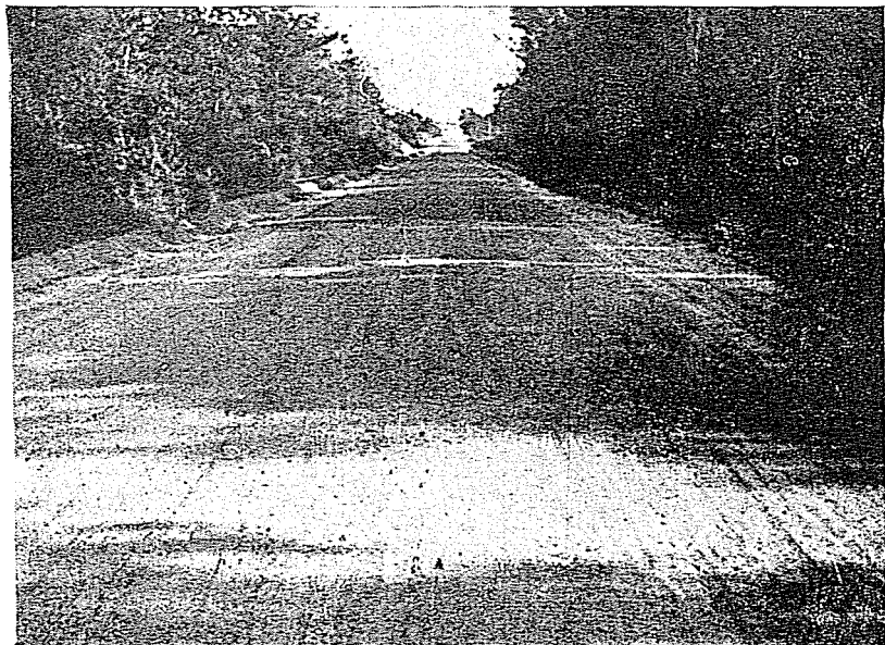
Fig. 20. — Carolina del Sud. — Estabilización de suelo con cemento portland, 15 a 2M cms. de espesor. — Unos 120 kgs. de cemento por m 3 . de suelo. Mezclado en seco, se agrega agua 10 a 12 ½ m. de mezcla y se compacta con rodillo de 5 toneladas.
