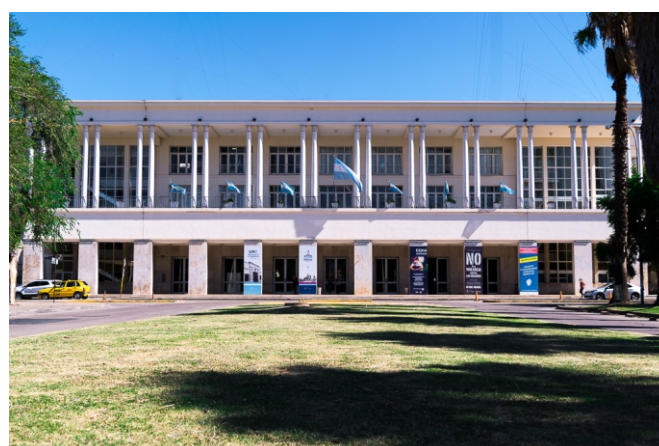
Vista Pabellón Argentina entrada a la Biblioteca segundo piso a la derecha.
