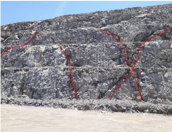
Fig. 13: TG 3.2.2F. Influencia de las zonas de falla. Talud EG 26 (31° 32.081S – 64°29.181 O). Altura de talud: 32 m.
