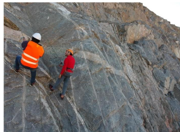
Fig. 3: Relevamiento de datos geotécnicos en altura. Ascenso por falla en cuña
