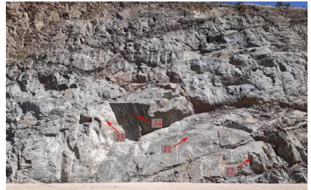
Fig. 4: Altura en la fotografía: 25 m. Talud EG 24 (31°31.559 S – 64°29.689 O).
