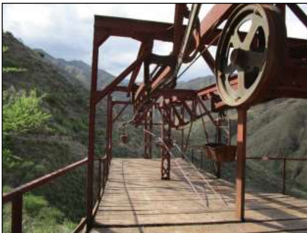
Fig. 8: Estación 3 del cable aéreo. (Foto original).
