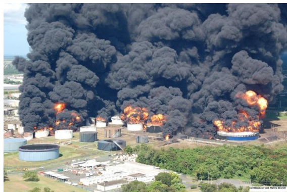
Figura 1: Incendio en una planta de almacenamiento de combustible en Bayamón, Puerto Rico, el 23 de Octubre de 2009 (Batista-Abreu y Godoy, 2011).
