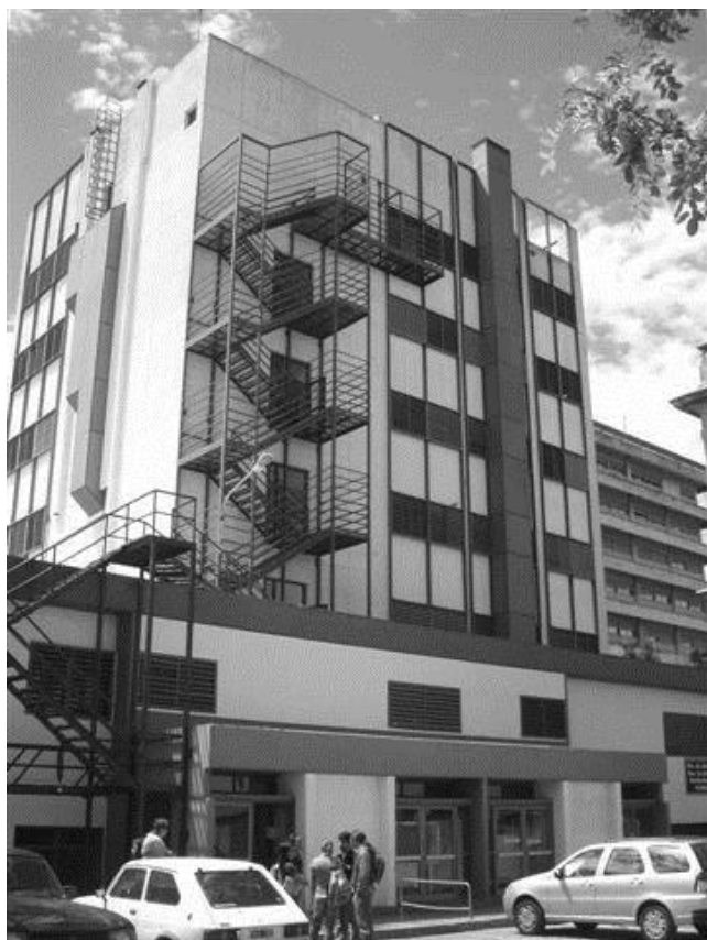
Fig. 13: En 1985 el Departamento de Geología se muda al edificio ubicado en la calle San Juan 670, el cual es compartido con el Departamento de Biología.
