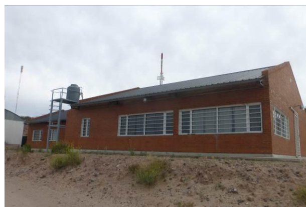
Fig. 13: Edificio del área de Geología, 2017.
