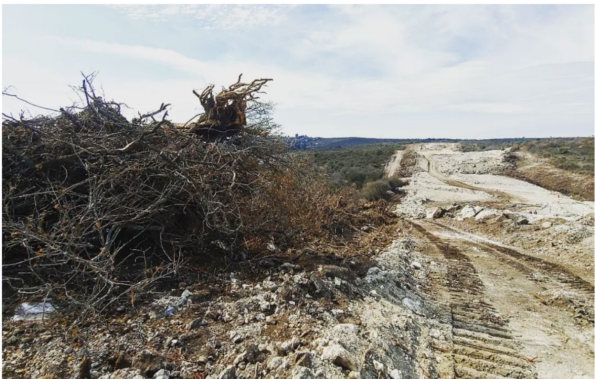
Fotografías N° 17 y 18: Avances de la obra de la autovía en zona roja de bosque nativo en Paravachasca, vía alternativa a la Ruta N° 5. 6 de agosto de 2022
