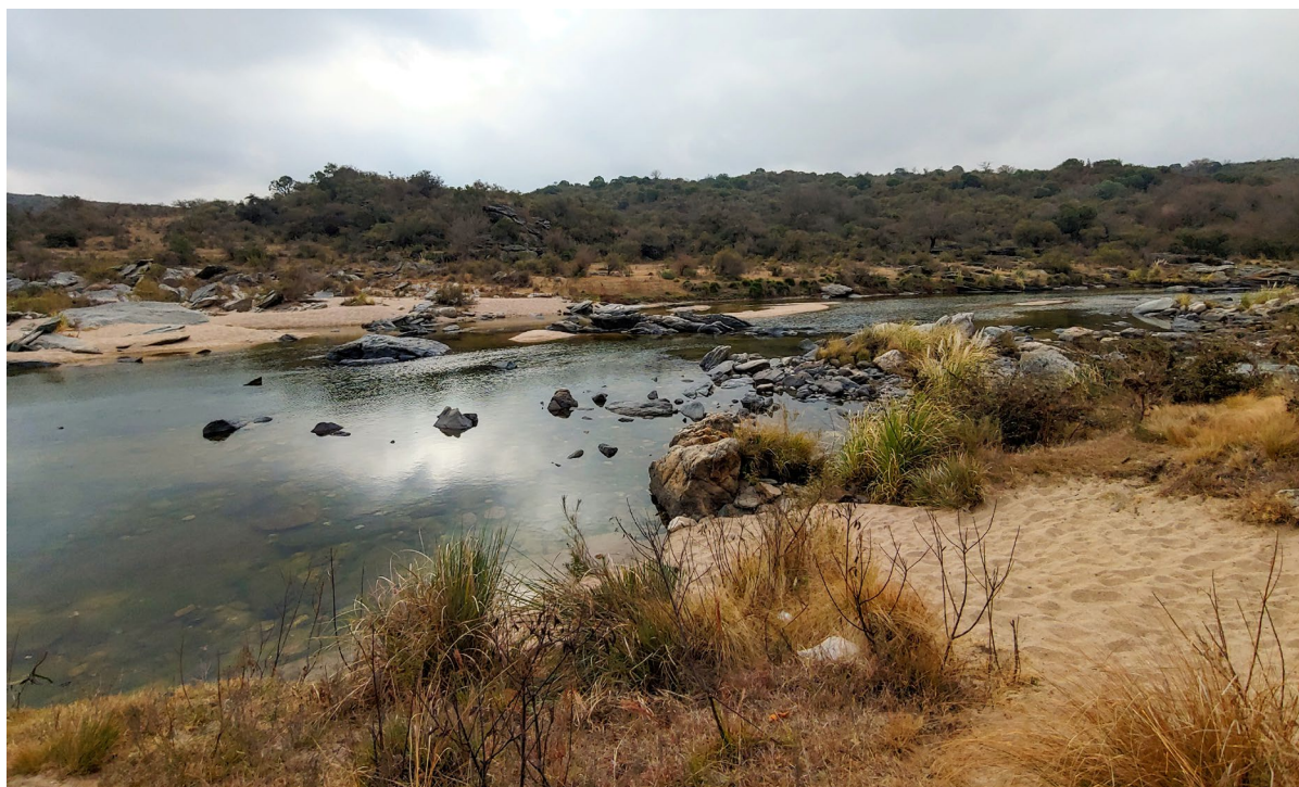
Fotografías N° 6 y 7: Zona del Río Yuspe donde ahora están desmontando para la obra de la Autovía
