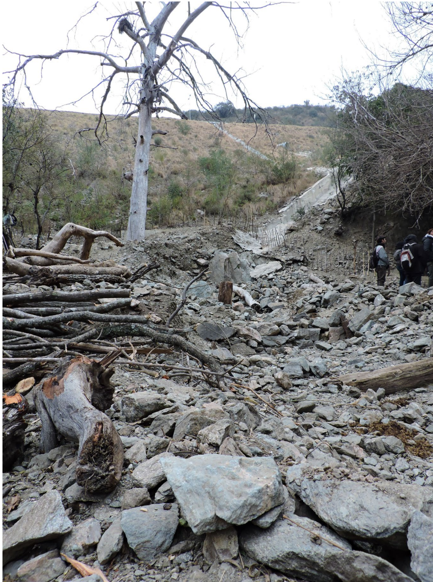
Fotografía N° 13: Zona de Lagunas, donde viven las familias afectadas por la construcción del puente De la Sota
