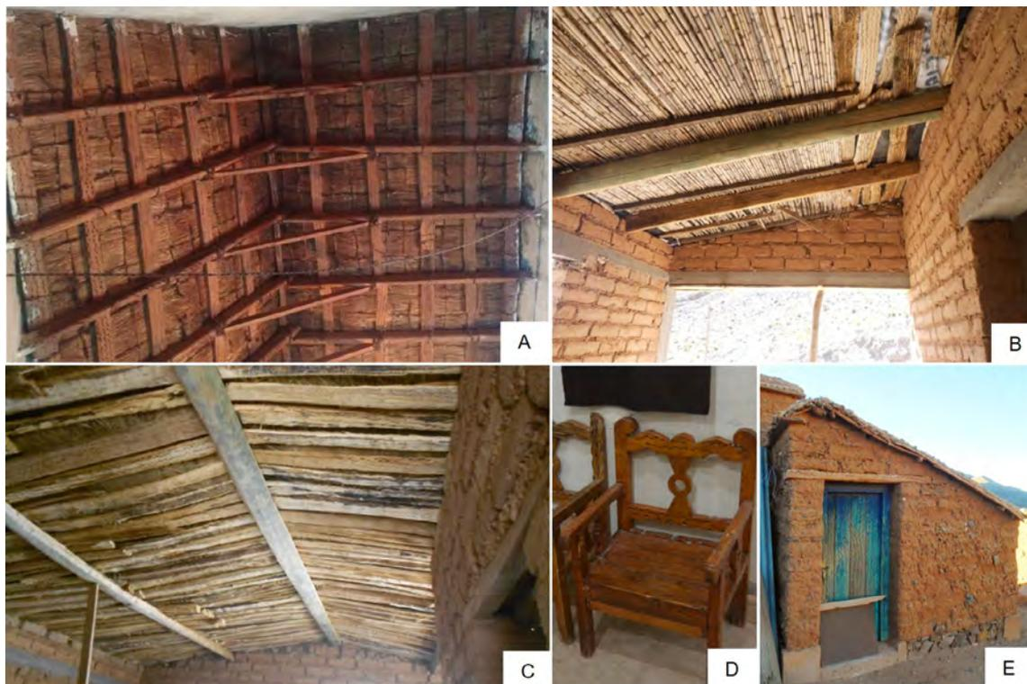
**Fig. 4.** Fotografías donde se observan en los techos **A:** estructura a dos aguas en maderas nativas. Cielorrasos de **B:** caña de castilla (*Arundo donax*) y **C:** cardón (*T. atacamensis*), con vigas de madera de eucalipto (*Eucalyptus* sp) y de pino (*Pinus* sp) respectivamente, y el uso de la madera de cardón en **D:** mobiliario y **E:** dinteles y cerramientos.
