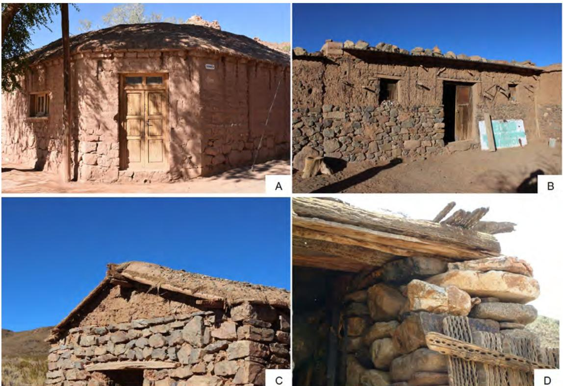
**Fig. 1.** Resoluciones técnicas en piedra y adobe para muros y estructuras de madera con terminaciones de paja y barro para los techos en arquitecturas en Susques, Jujuy, Argentina. **A:** fotografías de un domicilio en el pueblo de Susques, **B:** una casa de campo, **C:** oratorio en el ámbito rural del departamento homónimo, **D:** puesto en el ámbito de pastoreo de esta misma unidad doméstica.
