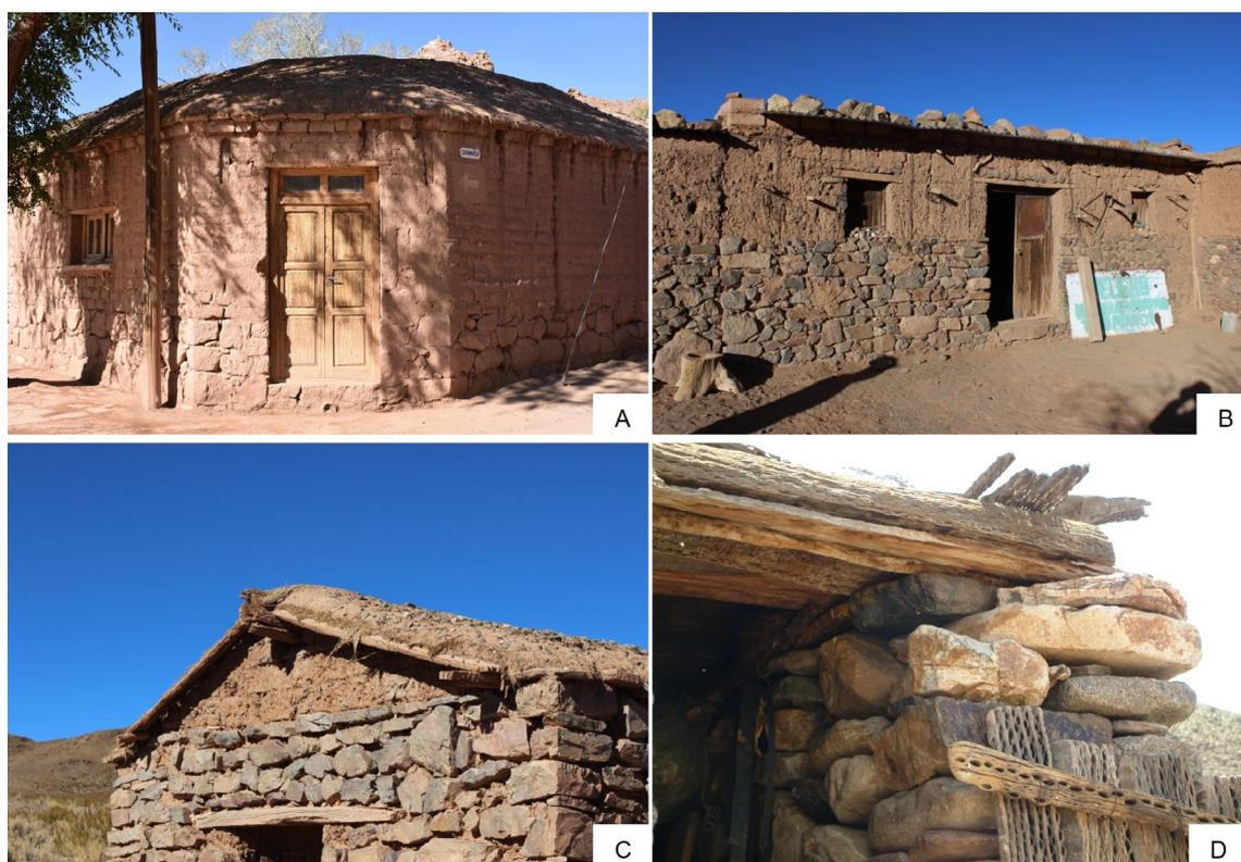
**Fig. 1.** Resoluciones técnicas en piedra y adobe para muros y estructuras de madera con terminaciones de paja y barro para los techos en arquitecturas en Susques, Jujuy, Argentina. **A:** fotografías de un domicilio en el pueblo de Susques, **B:** una casa de campo, **C:** oratorio en el ámbito rural del departamento homónimo, **D:** puesto en el ámbito de pastoreo de esta misma unidad doméstica.
